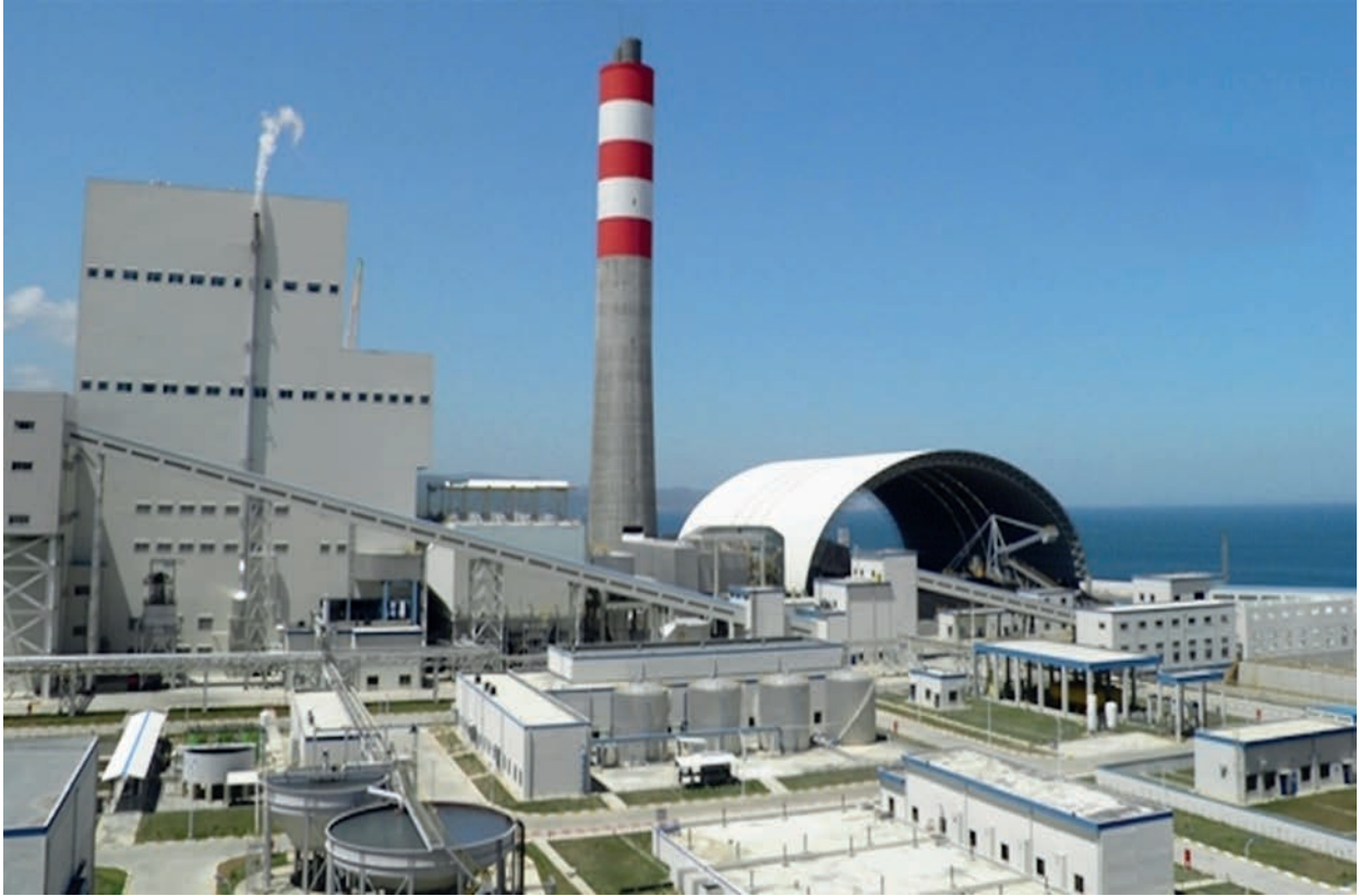
Bekirli Termik Santrali
